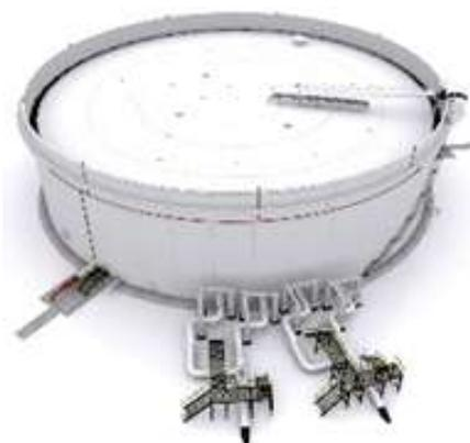
Резервуар вертикальный стальной с плавающей крышей (РВСПК)
